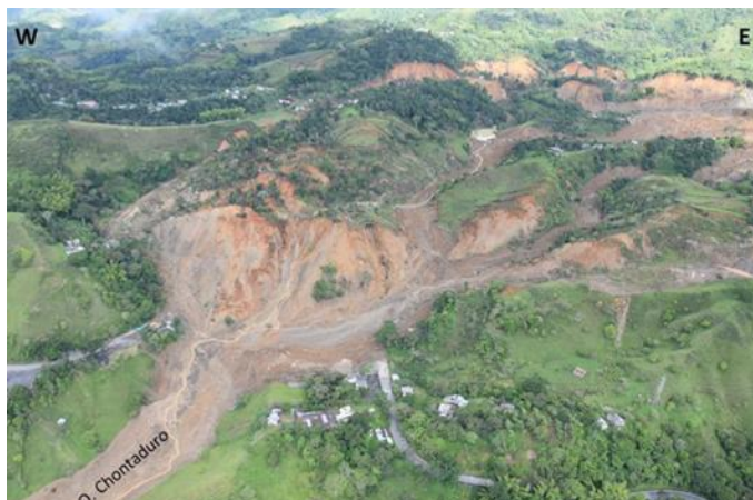
Figura 2. Panorámica del deslizamiento de Rosas, Cauca
